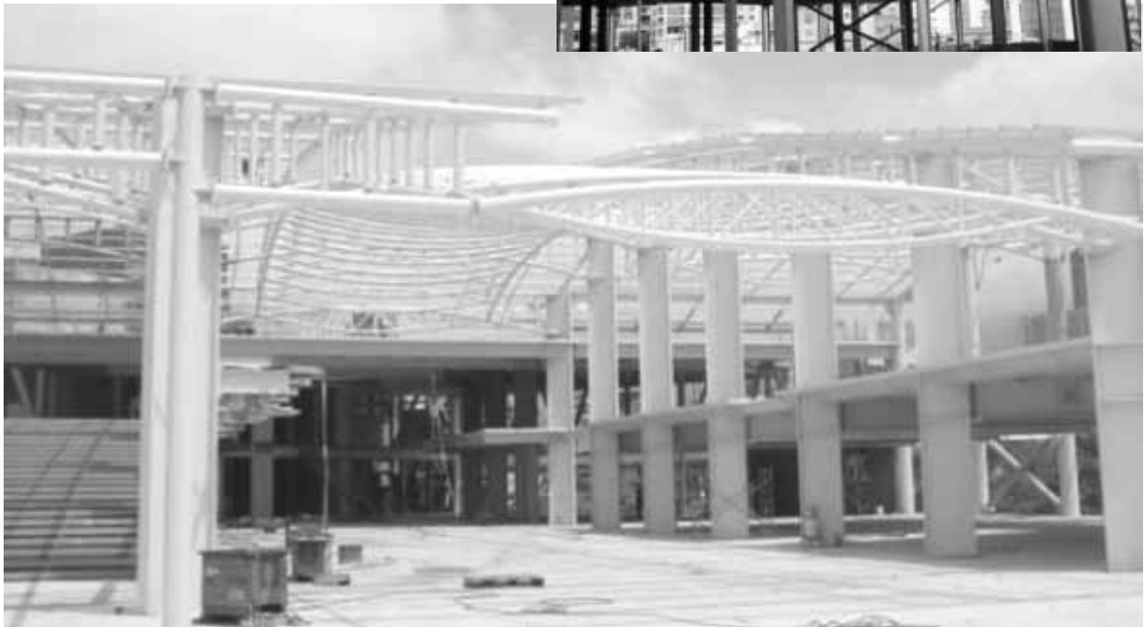
Figura 7: Estructura del auditorio, comedor y pasillo central entre ambos
