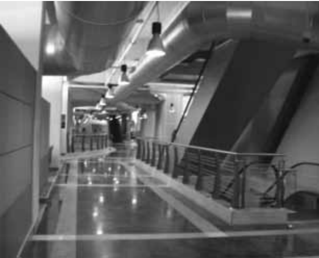
Figura 10: Pasillo en planta alta. Nótese la presencia de tuberías de instalación y la disposición de la iluminación, donde todo queda a la vista Fuente: Cortesía de Banesco
