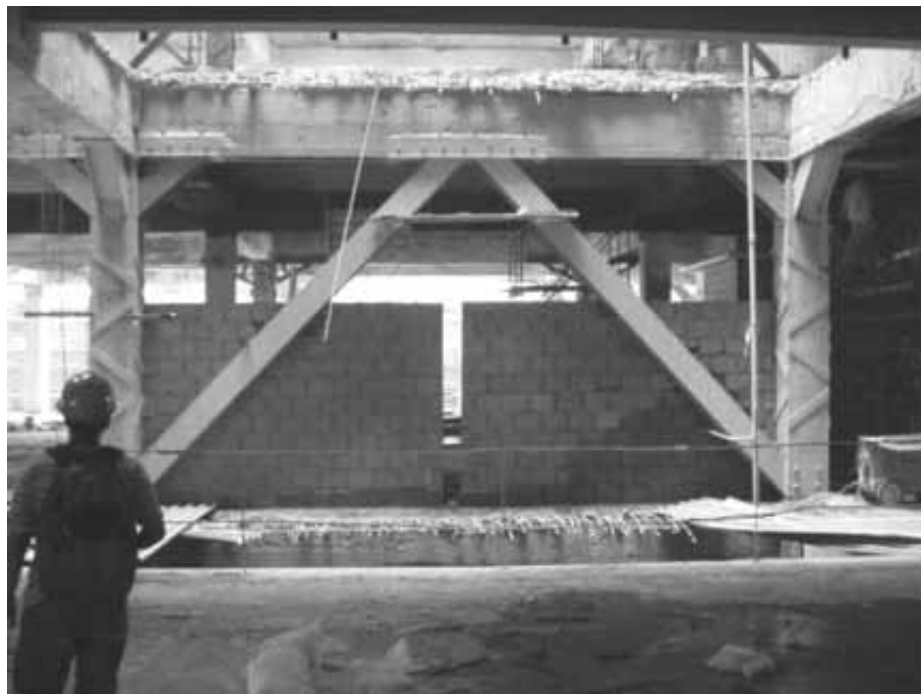
Figura 3: Refuerzos en estructuras existentes Fuente: Cortesía de Banesco
