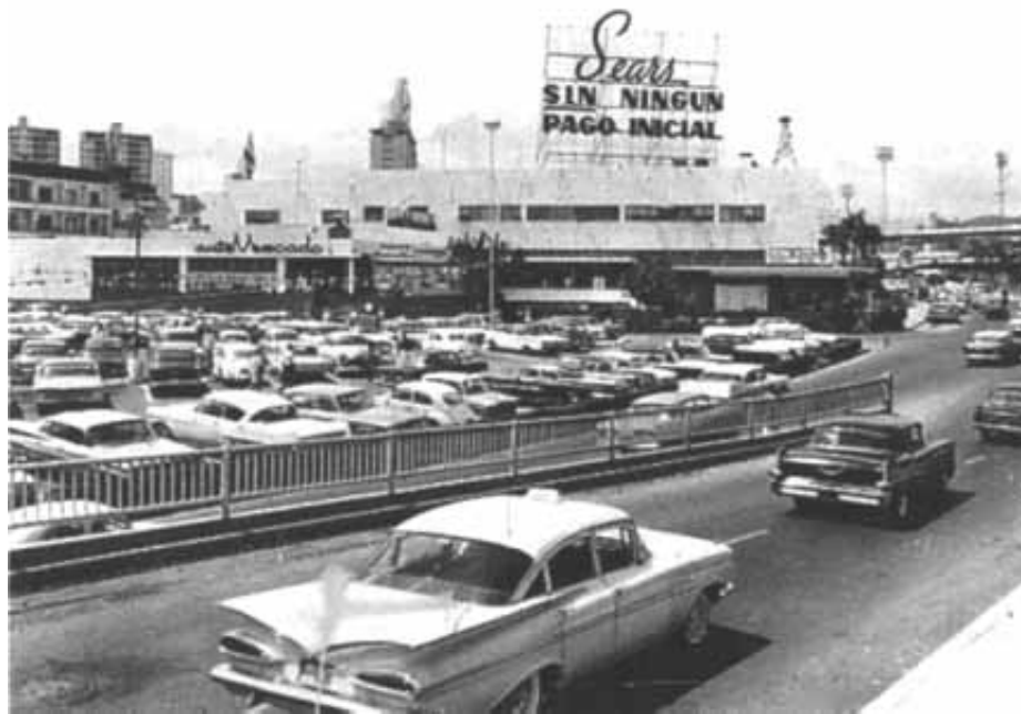
Figura 2: Antiguo edificio de la tienda por departamentos Sears Fuente: Banesco por dentro, tríptico
